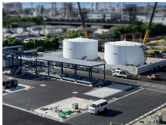
SAF の原料である廃食用油受け入れ施設
